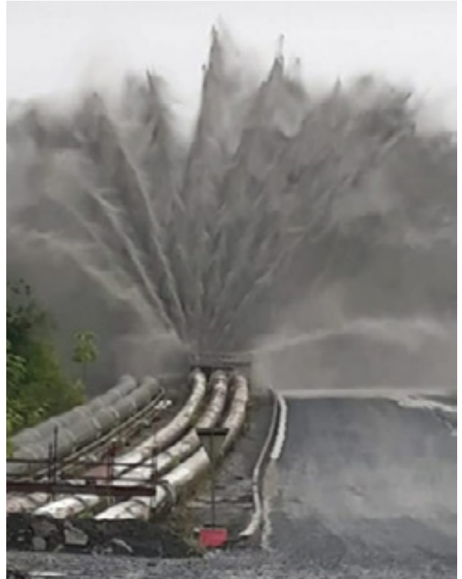
Rotura de una tubería de agua con contaminantes provenientes de la extracción de cobre en las instalaciones de Minera Panamá, en el distrito de Donoso, Colón, el pasado 14 de julio de 2021. El derrame consecuente tiñó de gris las aguas de la quebrada Chicheme y el río Pifá; sus afectaciones a largo plazo aún están por determinarse. Foto cortesía de la comunidad de Nuevo Sinaí.
